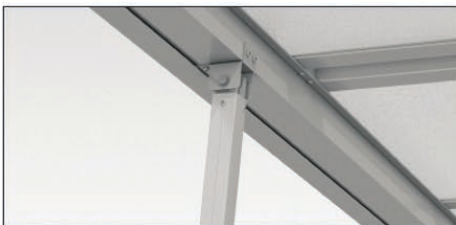
サポート取り付け(上部)
